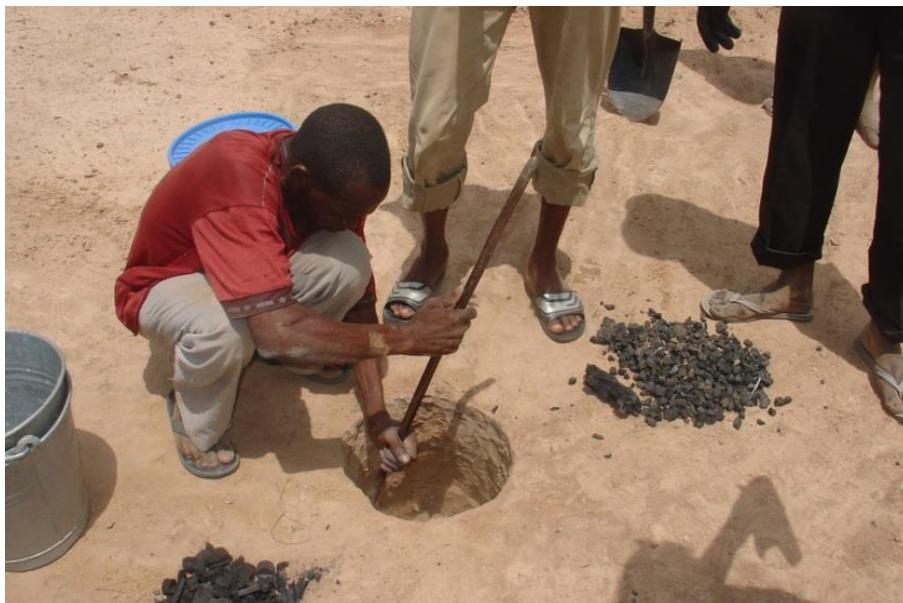
**FIGURE 30: THE MSP IS INSTALLED WITH THE TOP JUST BELOW GROUND LEVEL**
